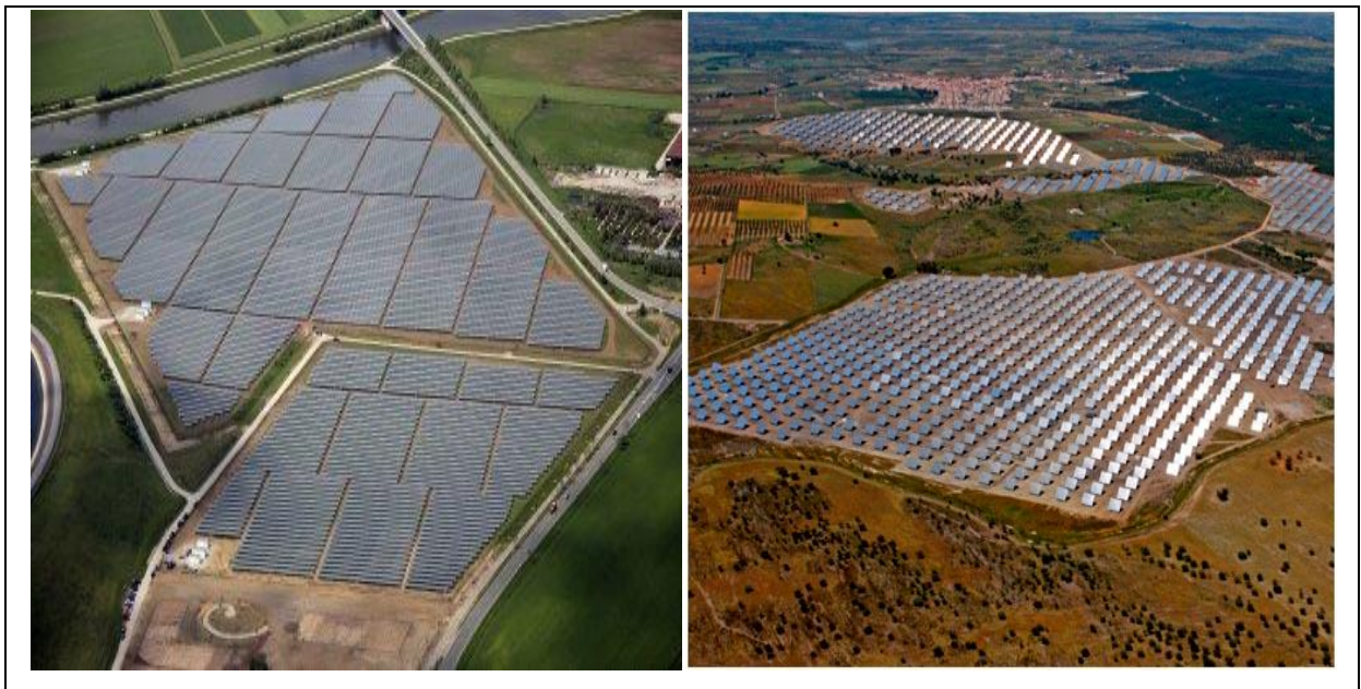
Figura 7: À esquerda a central solar fotovoltaica de Serpa e a direita a usina solar de Moura, ambas em Portugal.
